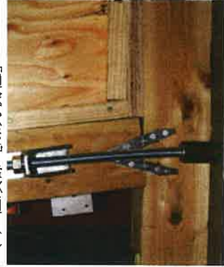
(f) 柱脚部 [加力側柱]
