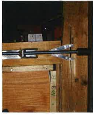
(h) 柱脚部 [非加力側柱]
