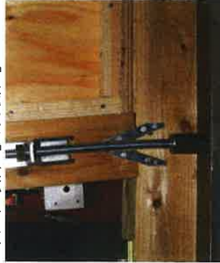
(f) 柱脚部 [加力側柱]
