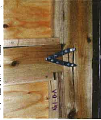
(g) 柱脚部 [中柱]
