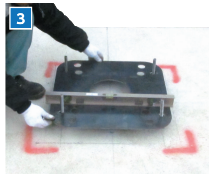
3 Bプレートを取付け4ヶ所の支持ボルト位置でレベルを仮決めする。
