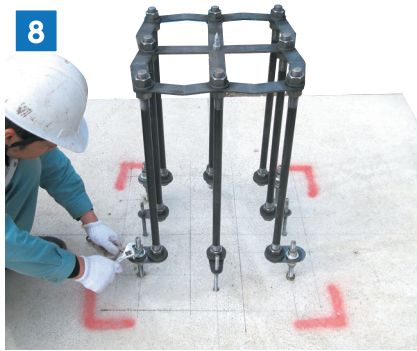
8 アンカーマンRフレーム本締め。
