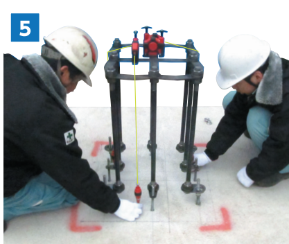
5 上部プレート上に下げ振りを2ヶ所以上取付け、ヨリ墨に正確に合わせる。
