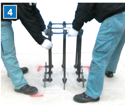
4 アンカーマンRフレーム取付け。
